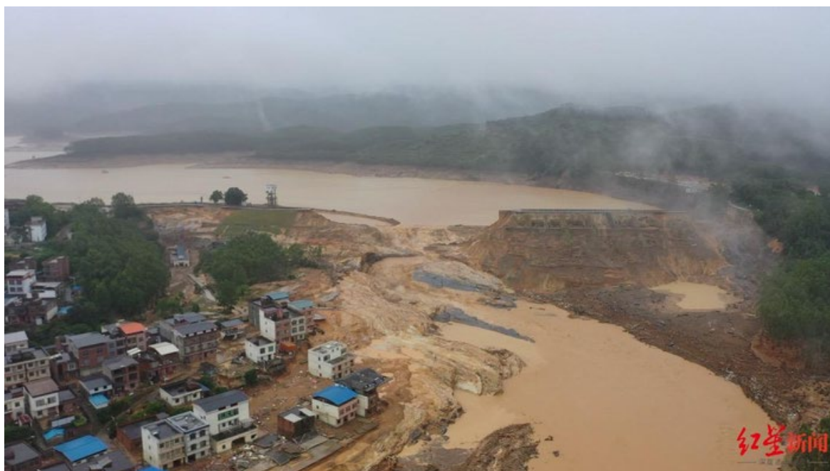
图2 六蓝水库溃坝后坝体缺口及近坝下游区域的航拍画面。图中可见坝体较大缺口、浑水外泄及近坝下游受影响区域。该照片反映灾后总体场景，但不能单凭照片确定初始缺口位置、漫顶与局部决口的准确先后、峰值流量或具体破坏机理。图片来源：红星新闻，《广西六蓝水库溃口前后关键12小时：受困者与救助者》，2026年7月11日。
